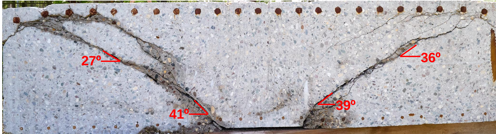
Характер образования трещин
