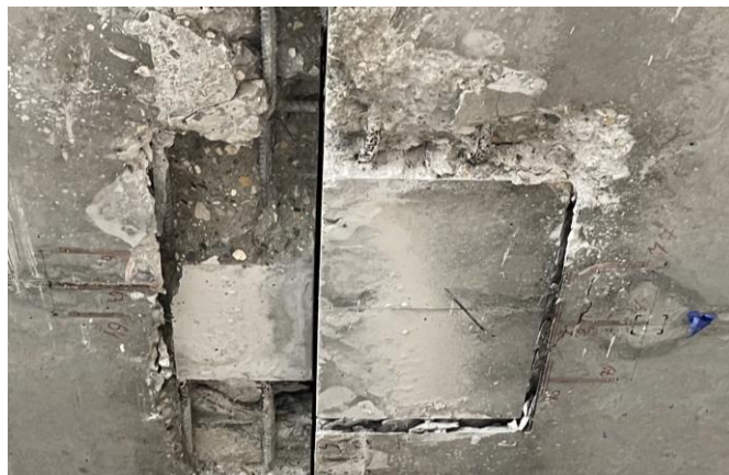
Характер разрушения сжатого бетона в окрестности опирания плит.
