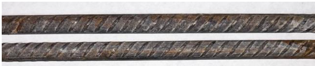
Арматура до коррозии
