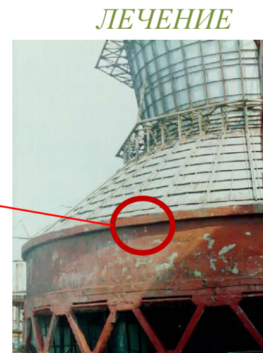
Устройства для усиления опоры конфузора
