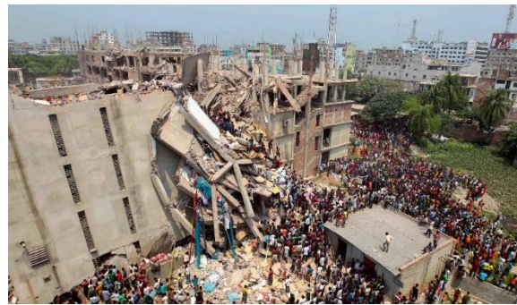
Обрушение части здания Рана Плаза (Савар, Бангладеш, 2013) из-за нарушений при строительстве и эксплуатации
