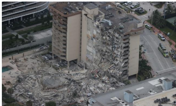
Обрушение части здания Champlain Towers South (Флорида, США, 2021) вследствие накопления коррозионных повреждений
