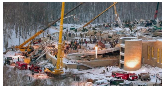
Обрушение здания «Трансвааль парк» (Москва, Россия, 2004) вследствие ошибок проектирования
