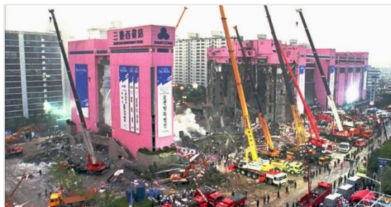
Обрушение здания торгового центра Sampoong (Сеул, Корея, 1995) вследствие ошибок проектирования и нарушений при эксплуатации
